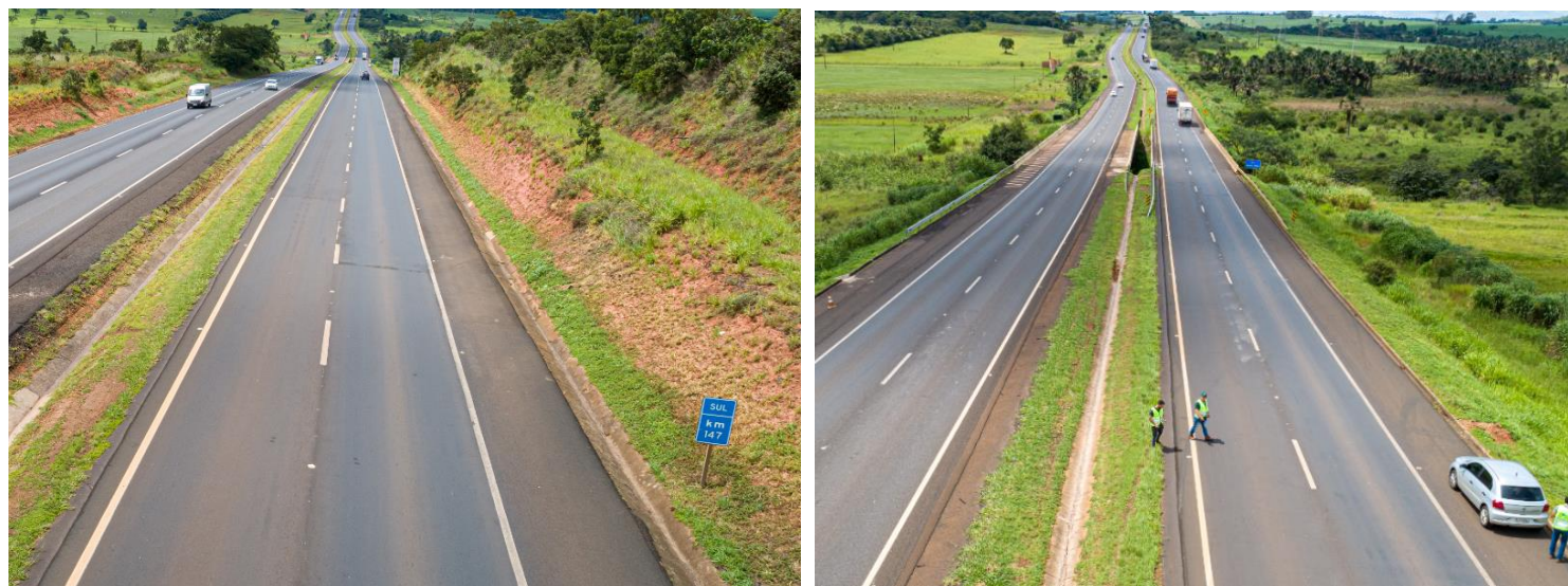
Figura 25 – imagem aérea do local
