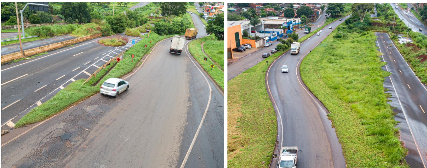
Figura 33 – imagem aérea do local
