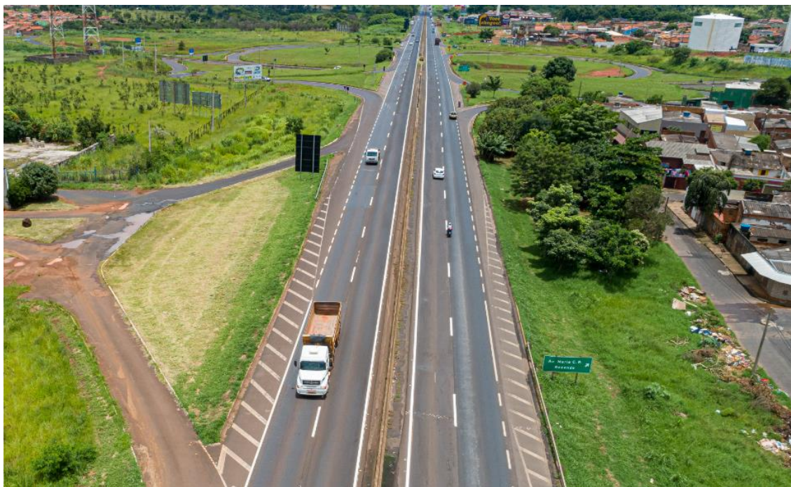
Figura 29 – imagem aérea do local
