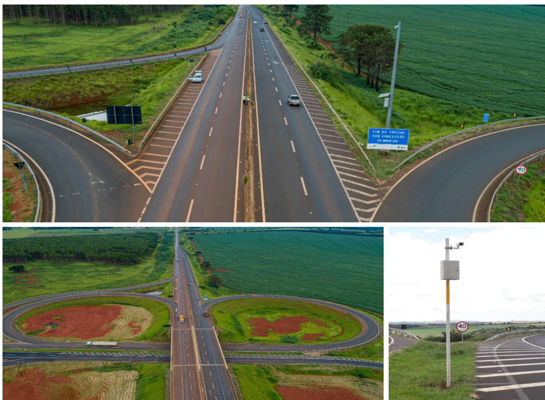
Figura 18 – imagem aérea do local
