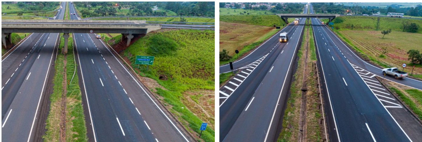
Figura 21 – imagem aérea do local
