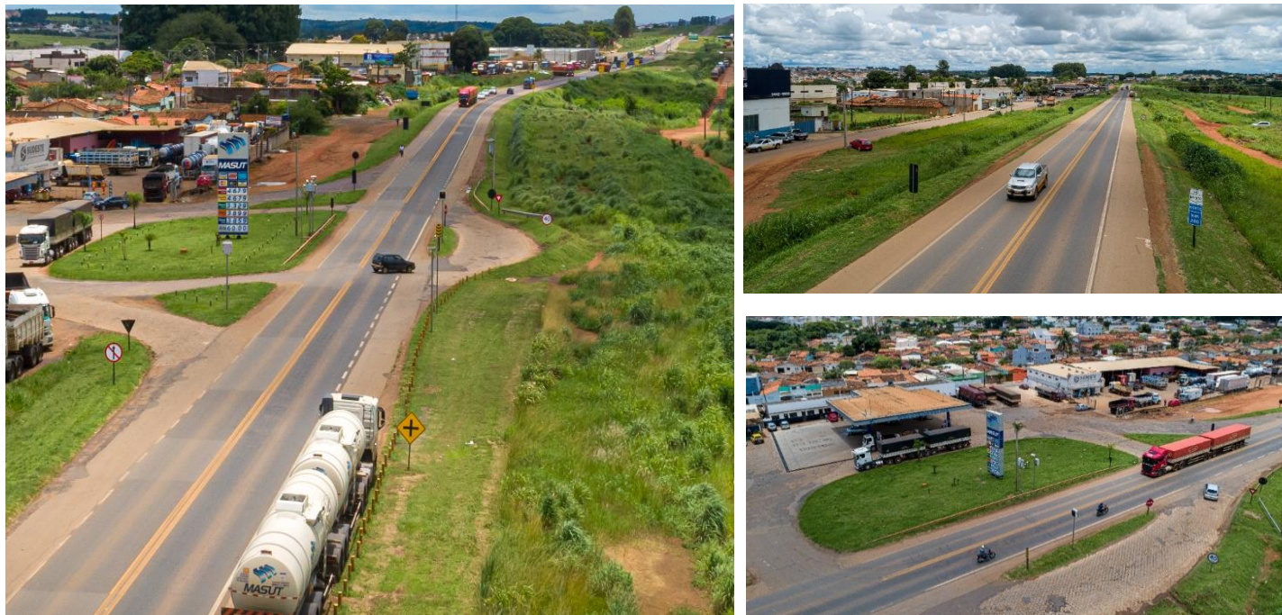
Figura 09 – imagem aérea do local
