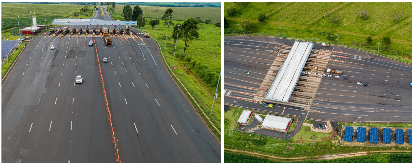
Figura 23 – imagem aérea do local
