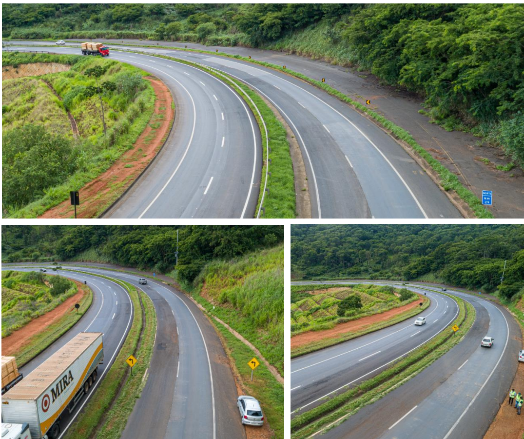
Figura 13 – imagem aérea do local
