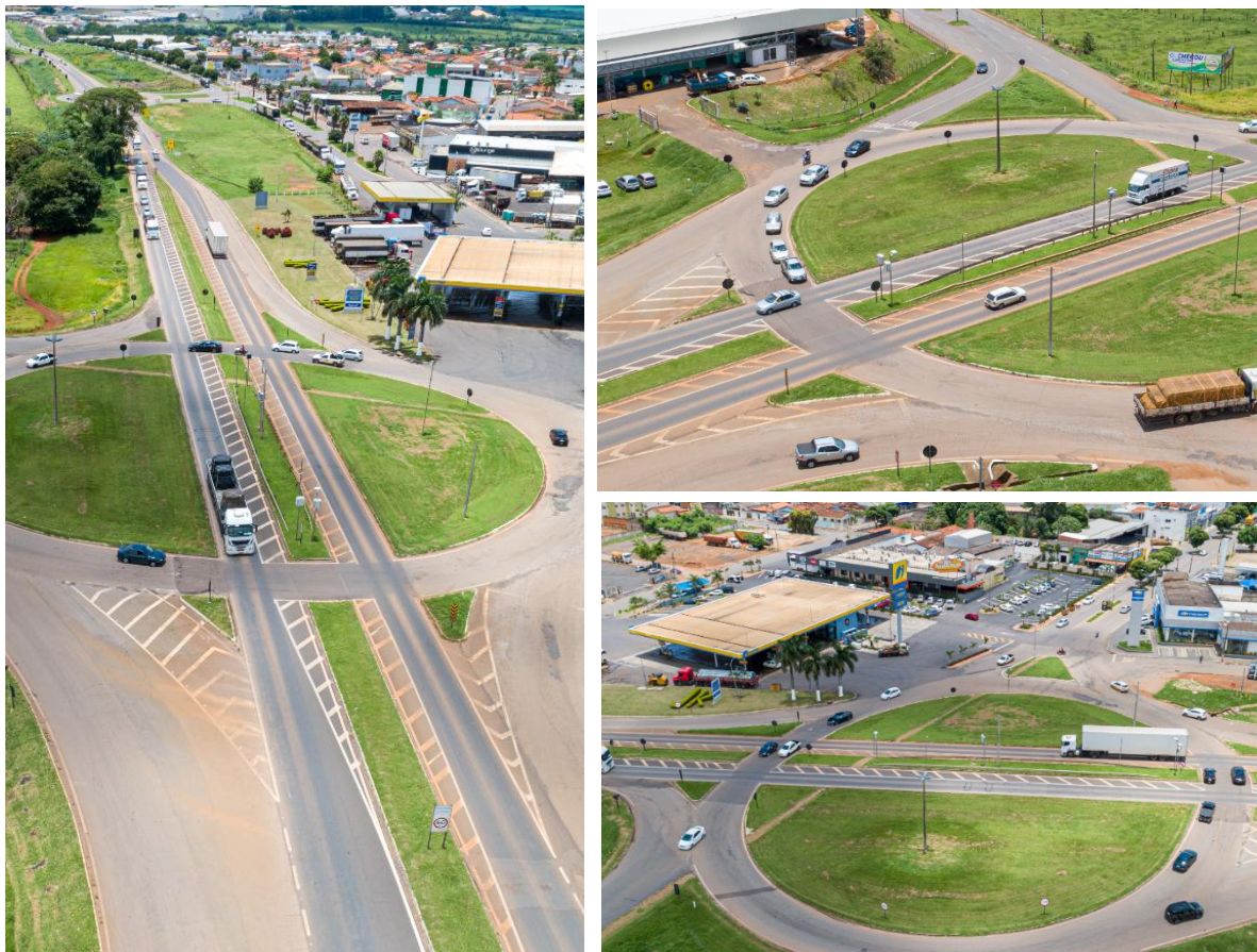
Figura 11 – imagem aérea do local
