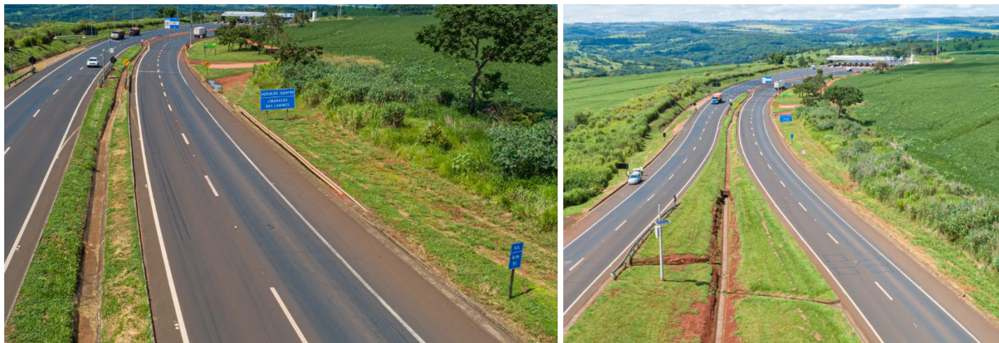
Figura 15 – imagem aérea do local
