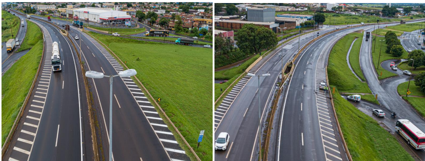
Figura 34 – imagem aérea do local
