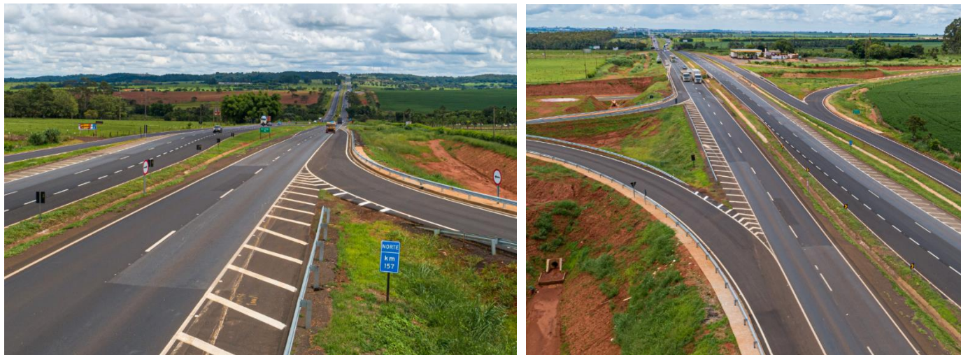
Figura 26 – imagem aérea do local
