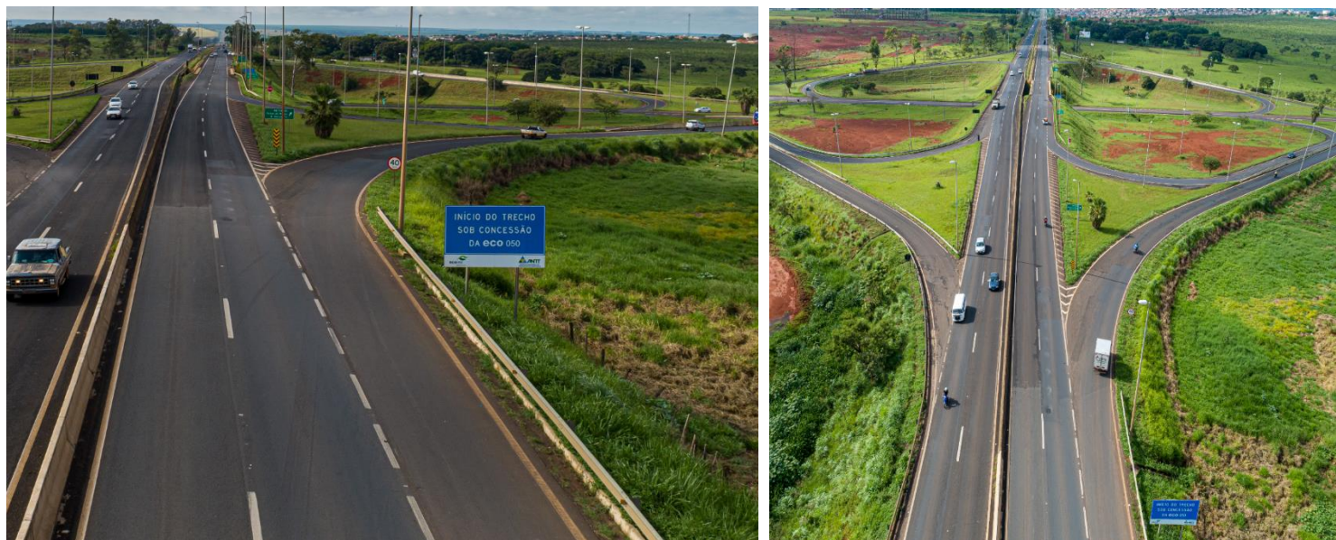
Figura 20 – imagem aérea do local
