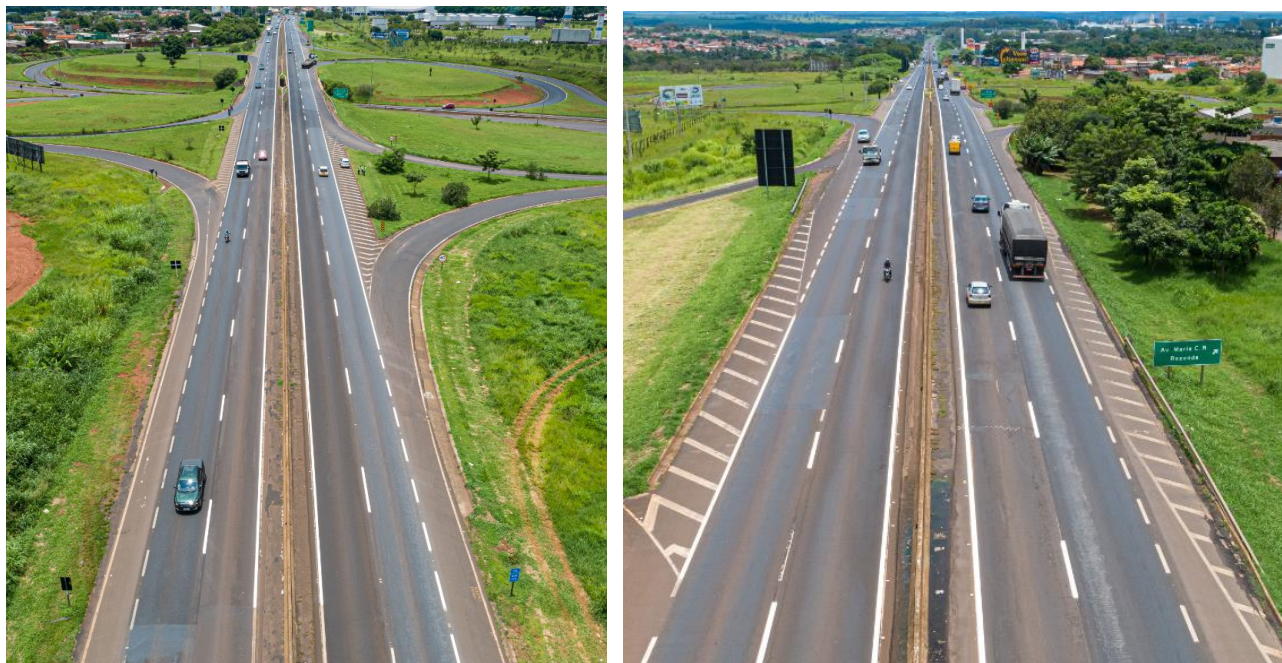
Figura 28 – imagem aérea do local
