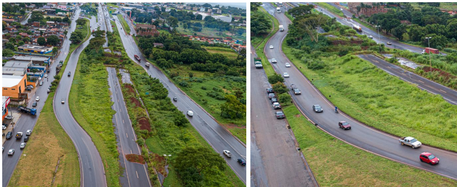
Figura 32 – imagem aérea do local
