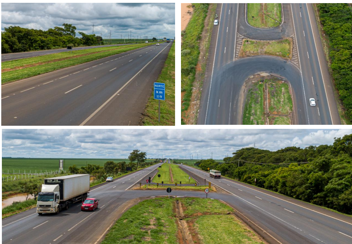
Figura 24 – imagem aérea do local
