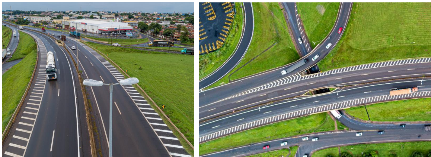
Figura 35 – imagem aérea do local
