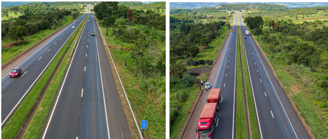
Figura 14 – imagem aérea do local
