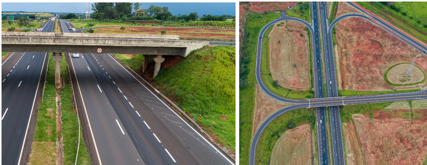
Figura 22 – imagem aérea do local
