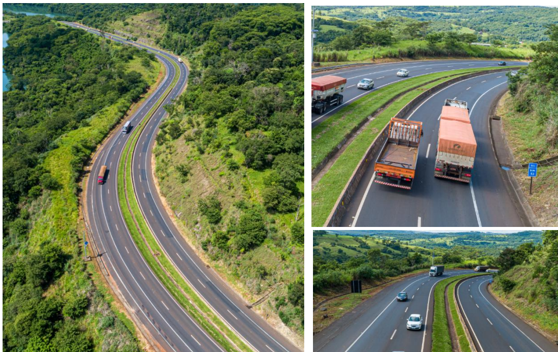
Figura 16 – imagem aérea do local
