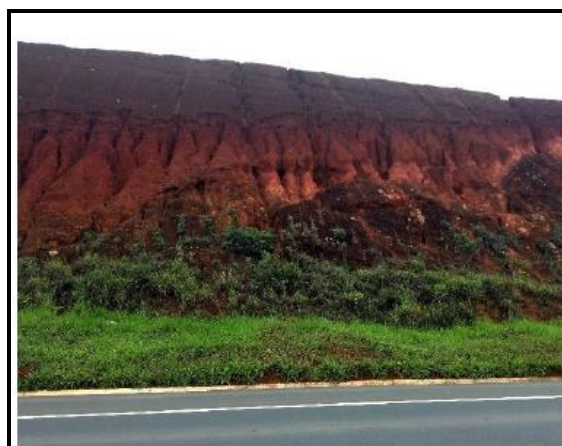
Figura 60: Erosão do solo e encostas não estabilizadas. Fonte: UFPR/ITTI, 2018.
