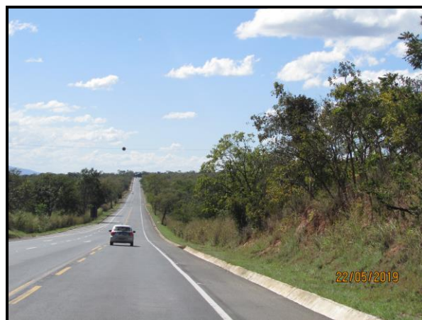
Figura 6: Trecho da rodovia pavimento em boas condições de trafegabilidade. Fonte: ECO 135 CONCESSIONÁRIA DE RODOVIAS S.A.
