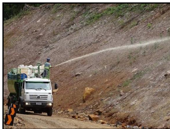
Figura 61: Hidrossemeadura para auxiliar na estabilidade da encosta. Fonte: STE, 2017.
