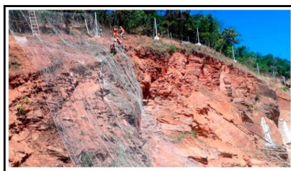
Figura 3: Estabilização de encosta em rodovia próximo ao município de Bocaiúva. Fonte: ECO 135 CONCESSIONÁRIA DE RODOVIAS.
