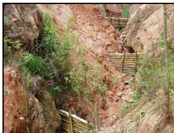
Figura 62: Paliçada de bambu como método de recuperar voçorocas. Fonte: Embrapa, 2015.
