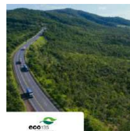
CONCESSIONÁRIA ECO135 363,95 quilômetros da BR-135 – Estado de Minas Gerais.
