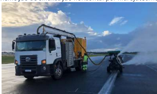
Figura 23– Remoção de sinalização horizontal por hidrojateamento
