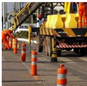
Balizador Cilíndrico Delimitador Flexível – ABNT NBR 16658
