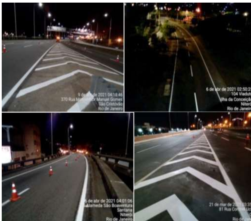
Foto 26 Campanha para revitalização da sinalização horizontal
