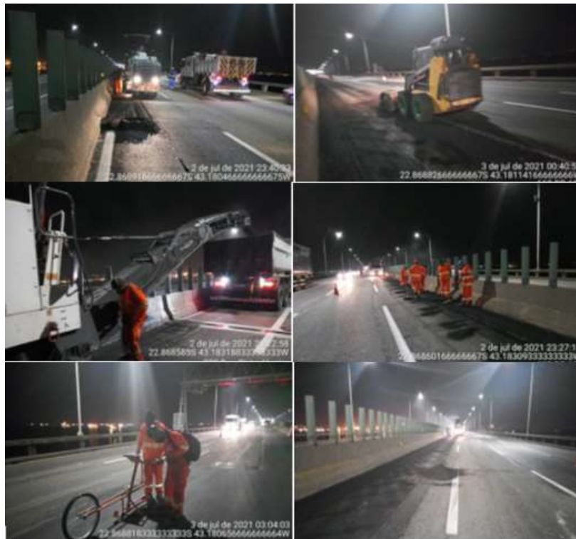
Foto 24 Serviço de Recuperação do Pavimento
