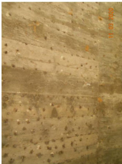
Foto 5. Fissura com efflorescência na laje.
