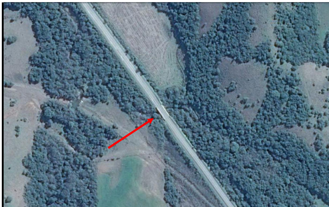
Figura 1: Localização geral da obra (ver seta)
