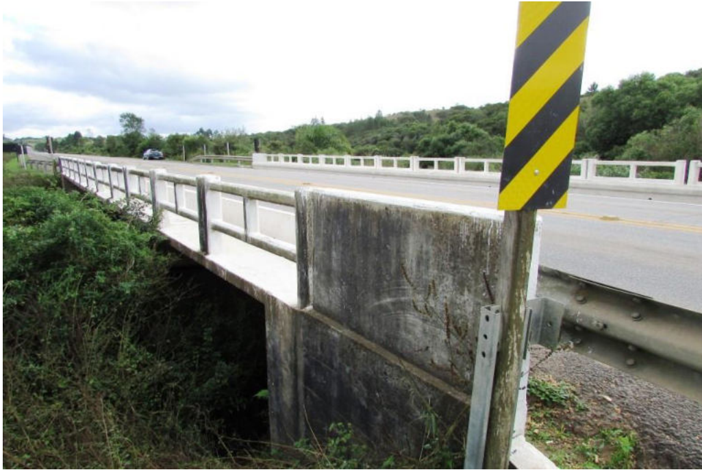
Foto 03 Vista lateral longitudinal do lado Oeste da OAE.
